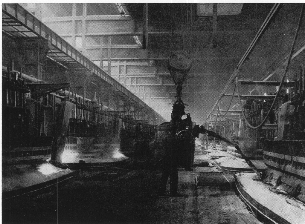
L'intérieur des salles d'électrolyse à Inota et à Ajka
